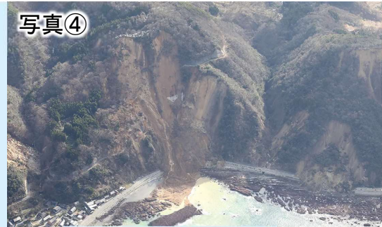
国道249号法面崩落
