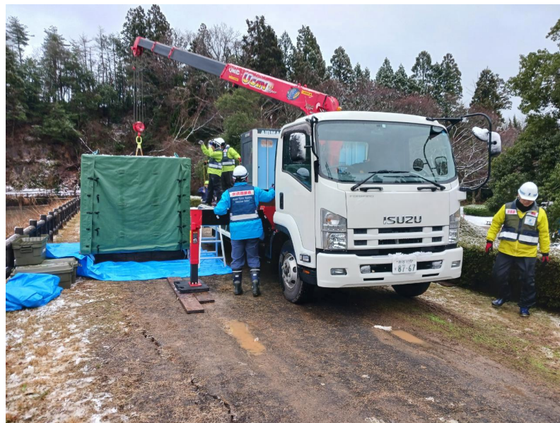
7日(日) 設置作業開始
