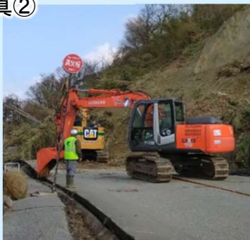
国道249号作業状況
